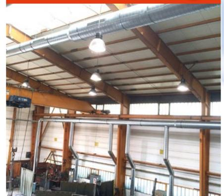
Bei der Schichtenlüftung werden die bewährten und zertifizierten Anlagen der Baureihe Filtercube und ZPF verwendet. Über Rohrleitung wird die Rohluft im oberen Hallenbereich erfasst und nach der Filtration dem Arbeitsbereich zugeführt, die schadstoffhaltige Luft wird nach oben verdrängt.
