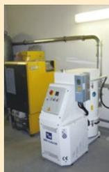
Die VACCUBE 55 NF1 mi 5,5 kW Leistung spart Energie durch den eingebauten Frequenzumrichter. Sie ist geeignet für bis zu 6 Arbeitsplätze.
