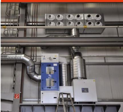
Die BlowTec zeichnet sich besonders durch den modularen Aufbau aus und passt sich flexibel an die betriebliche Gegebenheiten an. Bei der BlowTec ist eine besonders kurze Lieferzeit und schnelle Montage gewährleistet. Die Luftverteilung erfolgt über ein Plenum mit Weitwurfdüsen.
