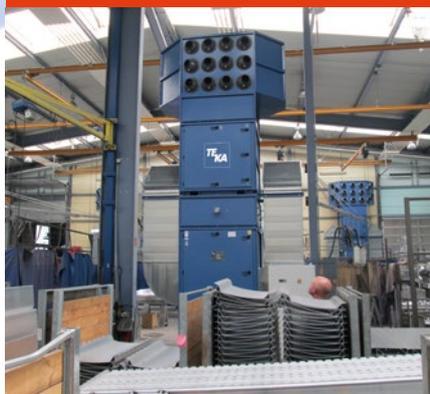
Mit AIRTECH-Systemen lassen sich große Luftmengen bei relativ niedrigem Stromverbrauch bewegen und Schadstoffe zuverlässig filtern. Die Anlage benötigt keine Rohrleitung. Als Besonderheit lässt sich die AIRTECH mit einem Heizregister ausstatten, so dass die Anlage gleichzeitig als Luftfilter und als Heizung fungieren kann.
